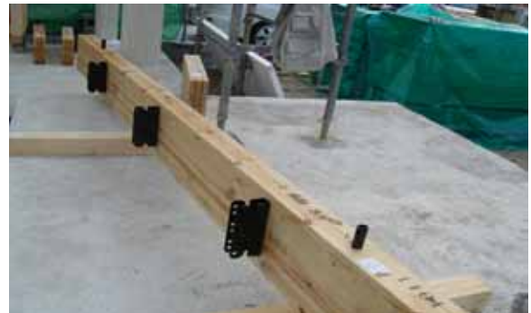
MSフレームシステム梁受、柱受け部分(金物)
