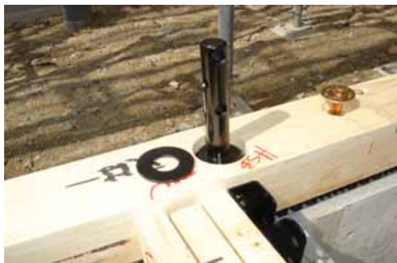
HSB-30(3KN用ホールダウン金物)
