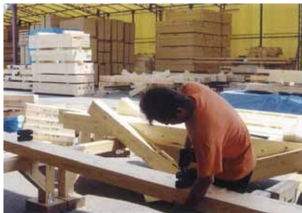
工場内金物取付け
