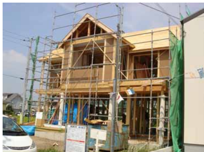
上棟後の全景
