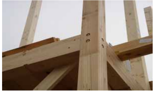
MSフレームシステム通し柱、胴差し取付け仕口部分
