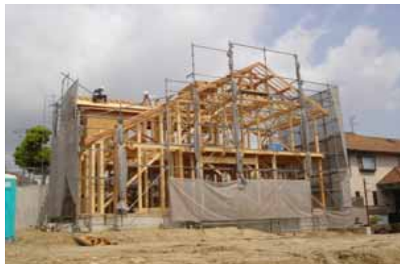
MSフレームシステム上棟建物
